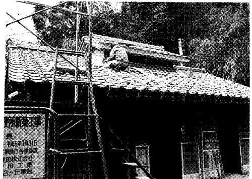
信越 入園者用トイレ新築工事
