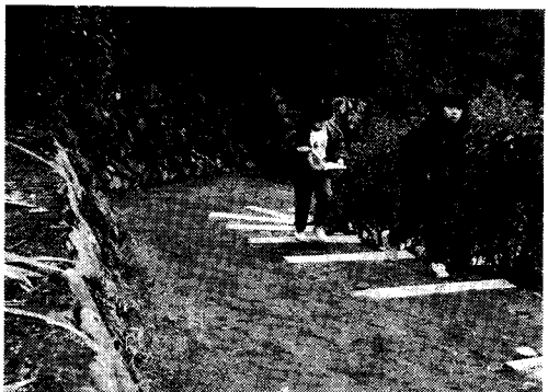
宿場 旧三澤家前園路改修（片側スロープ化）
